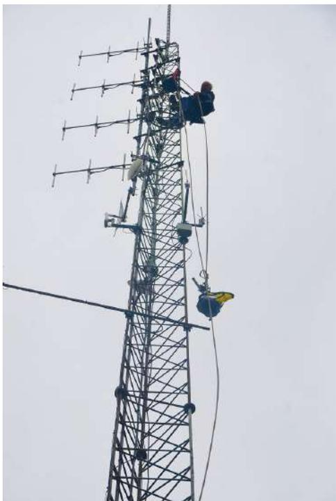
*A gauche : Voilà, le montage est terminé en haut. On aperçoit que la bretelle est fixée à l'extérieur de la flèche. La jointure entre les deux coax est protégée avec du tape vulcanisant pro.*
