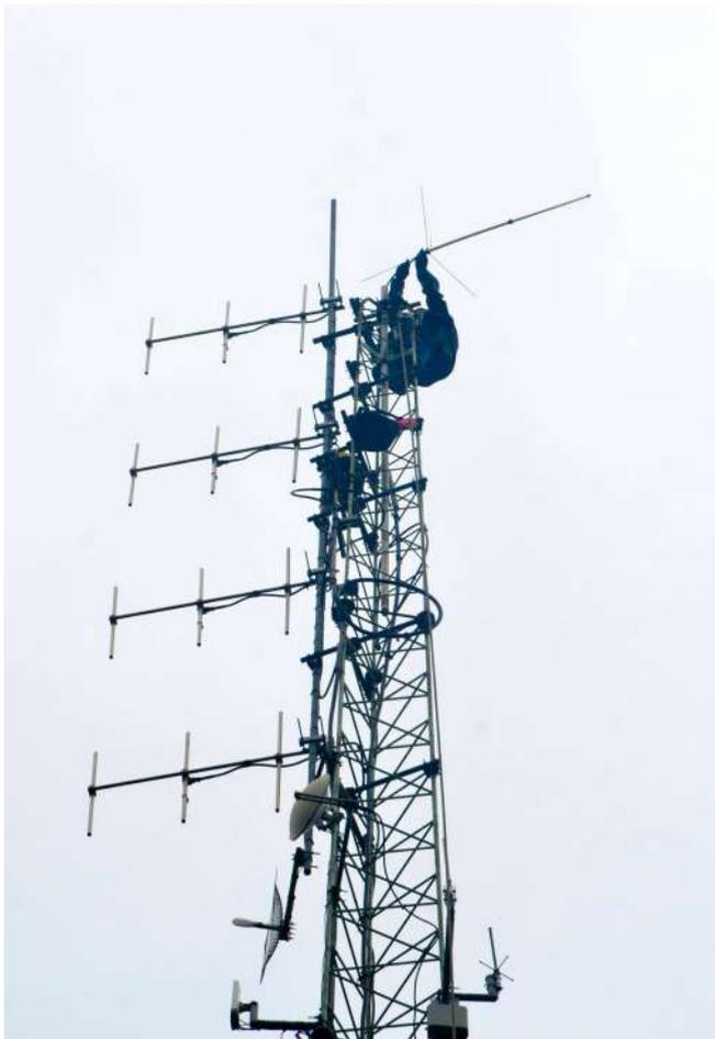
*La flèche est tenue avec quatre boulons en inox à l'intérieur du mât. Et à gauche on voit l'antenne colinéaire de RCF.*
